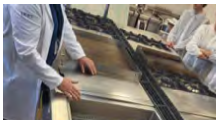
IMAGEN 9. FOGONES Y PLANCHAS DE COCINA
