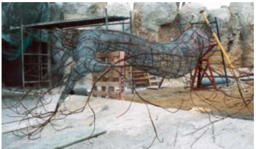
Foto nº 4: Tematización: esta estructura con varillas y malla metálicas forma el esqueleto de unas de las nueve ramas del baobab. Las ramas, cada una de las cuales pesa hasta 2.500 Kg, se elaboran en el suelo y son posteriormente izadas con una grúa hasta la copa del árbol gigante.
